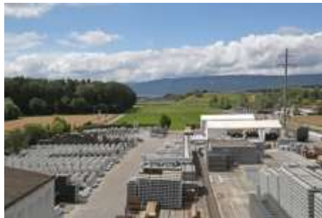
Areal der geplanten Erweiterung
