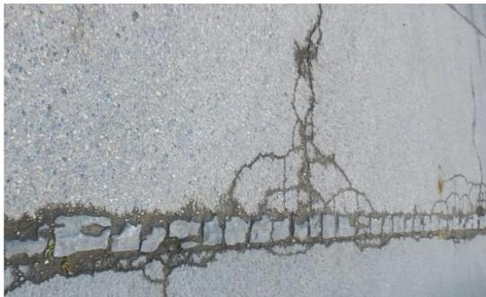
Abbildung 4: Typischer Zustand Abschlüsse (Quelle: Feldaufnahmen März 2024)
