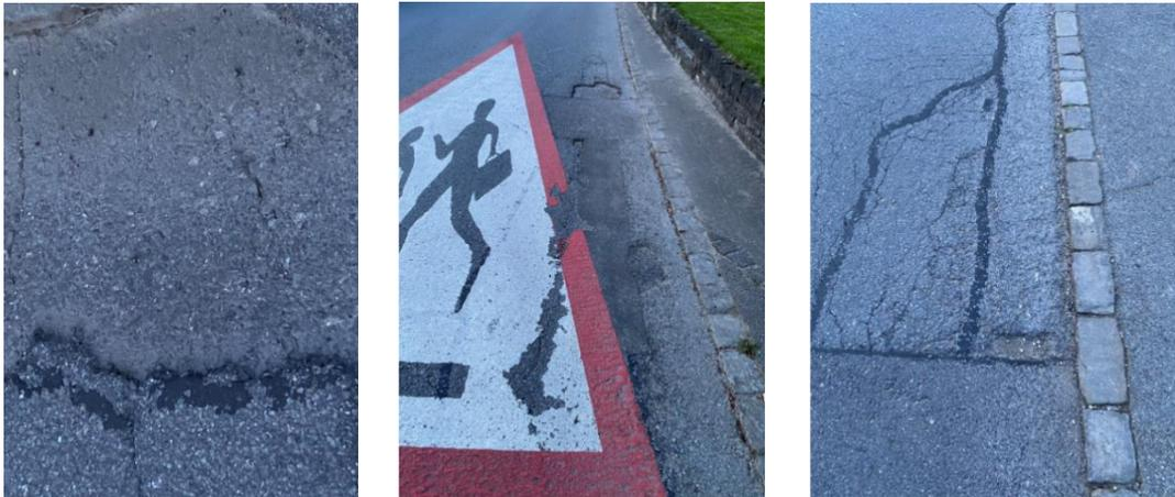
Abbildung 1, 2 und 3: Typischer Belagszustand von der Treitengasse (Quelle: Feldaufnahme März 2024)
